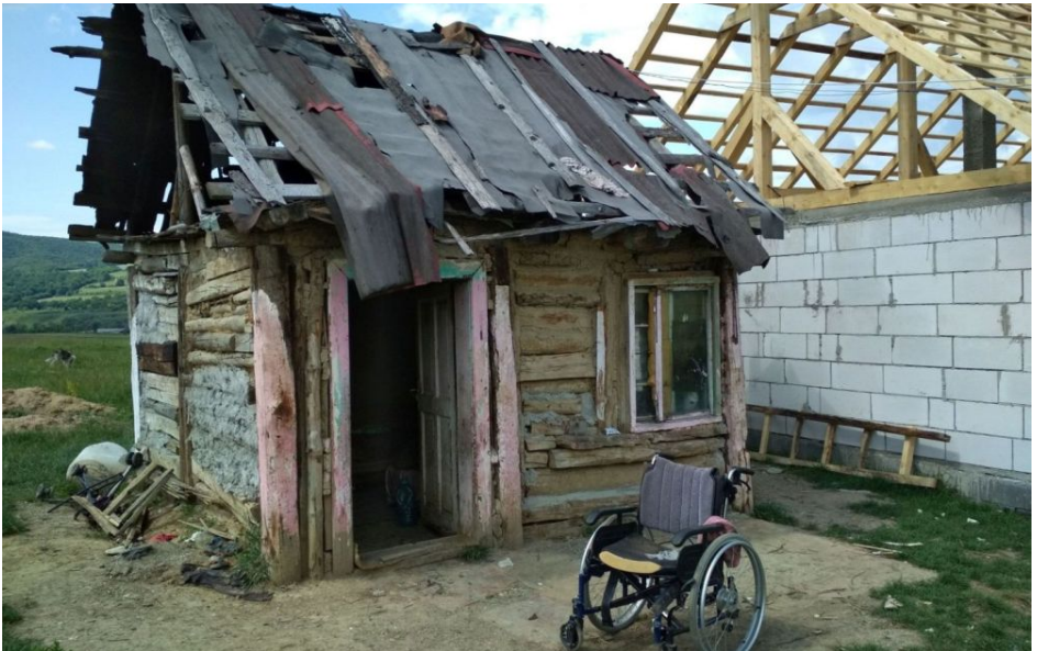
Derzeitiges „Wohnhaus“ und begonnener Neubau
